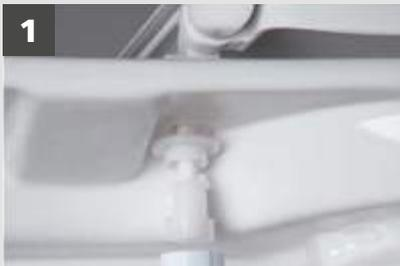
1 Introduire l'écrou d'assemblage de l'abattant dans le WC.
