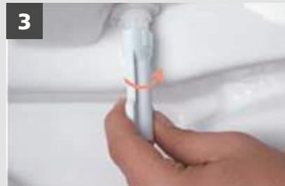
3 Faire pivoter l'écrou rapide dans le joint conique à l'aide de la clé et l'installation de l'abattant est terminée.
